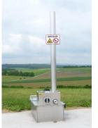
Condotta di scarico in sovrapressione c. flangia DN 150 / DN 200 V2A, lunga 3 m
