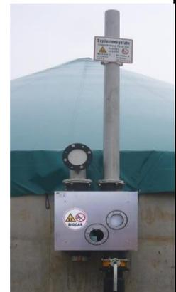
Предупредительная табличка взрывоопасной зоны МЕЖДУНАРОДНАЯ, простая, на пластине из нержавеющей стали 304 в комплекте с трубными зажимами DN 150 / DN 200 / DN 250 / DN 300.
